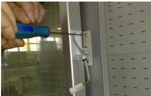
10. Вынуть технологическую заглушку и соединить провода.
