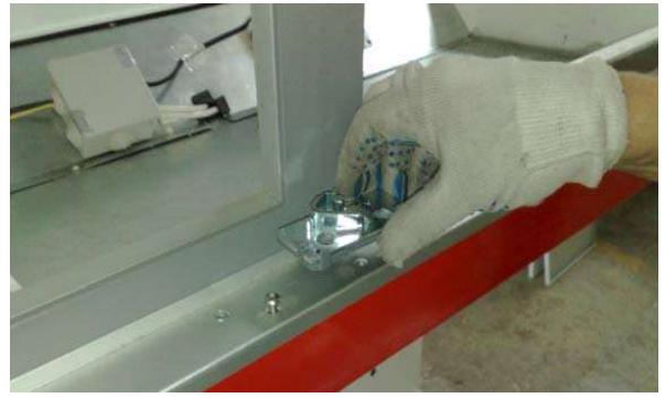
4. Установить фиксатор на нижнюю ось дверки.
