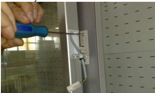
10. Вынуть технологическую заглушку и соединить провода.
